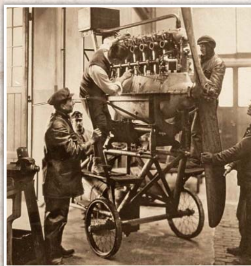
Továrna Austro-Daimler rok 1918. Letecká vrtule SIGMA je zde nasazená na motoru Austro-Daimler (15-litrový šestiválec), který patří do letounu Hansa - Brandenburg C.I. Poslední úpravy na motoru zde provádí osobně sám ředitel závodu Ferdinand Porsche (muž v košili a vestě).
