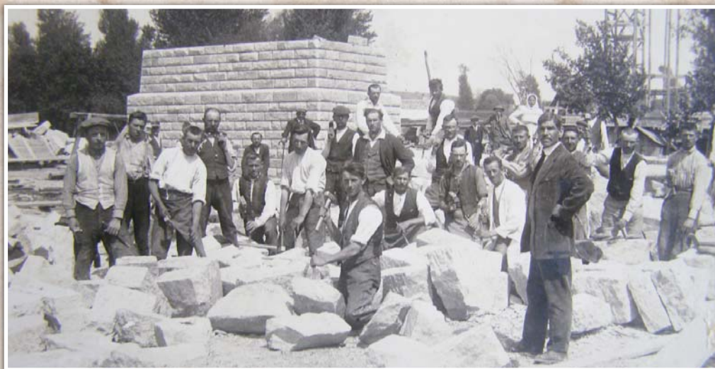
Rozestavěný lipovský viadukt v roce 1927. Správně se jedná o viadukt loucký, protože se nachází již na katastru obce Louky.
